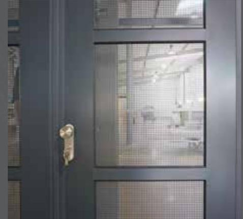
La porte avec les plaques d'acier perforées pour assurer la circulation d'air où c'est nécessaire.
